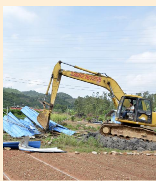
图为拆除现场
