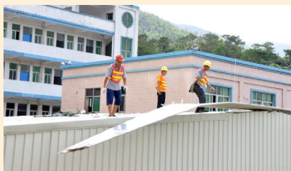
▲拆除罗马天生湖村小组某违建现场
